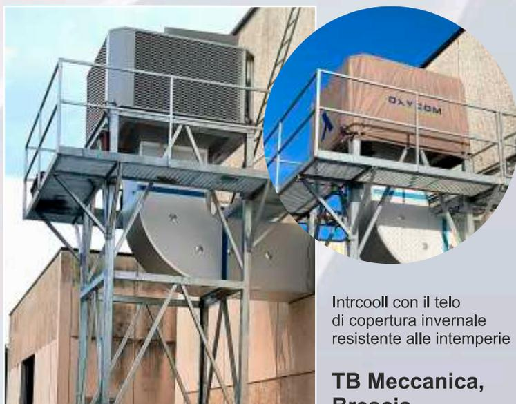
Intracool con il telo di copertura invernale resistente alle intemperie
